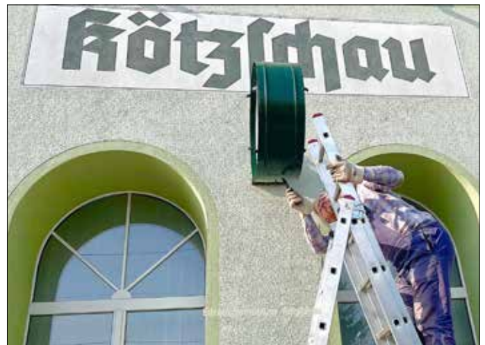
Wiederherstellung der Bahnsteiguhr. Neuanstrich des Gehäuses.
