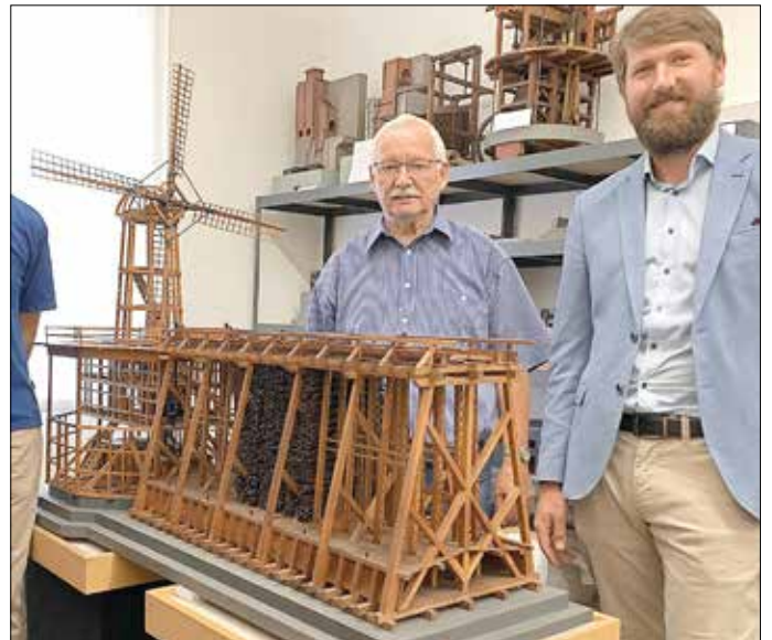
Modell der Saline Kötzschau mit Windkunst und Gradierhaus [10] Foto: M. Poppe
