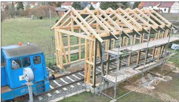
Zustand des Baus im März 2023 Foto: Eisenbahnmuseum Kötzschau / David Falk
