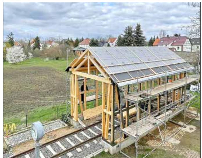
Dacharbeiten am Lokomotivschuppen. Foto: Eisenbahnmuseum Kötzschau/Mareike Müller
