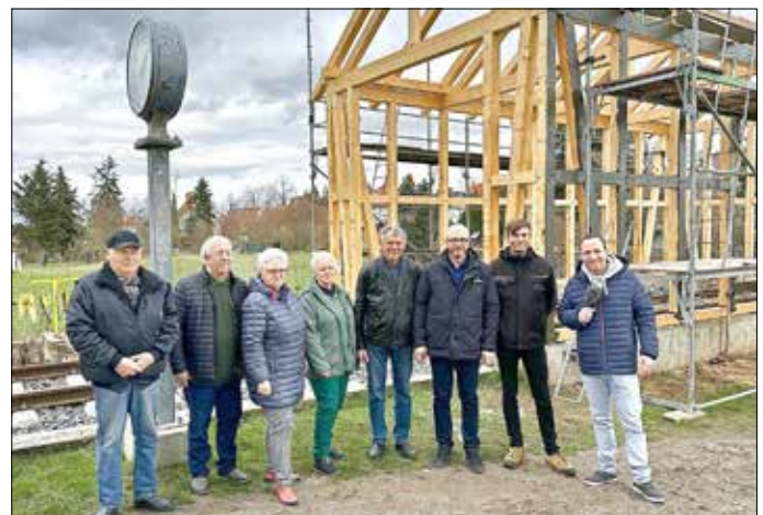
Gruppenbild mit dem Moderator der MDR-Sendung „Mach Dich ran!“ Mario D. Richard vor der Baustelle des Lokomotivschuppens. Foto: Eisenbahnmuseum Kötzschau/Daniel Falk
