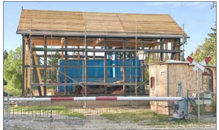
Der Lokomotivschuppen ist bereit zum Dachdecken.
