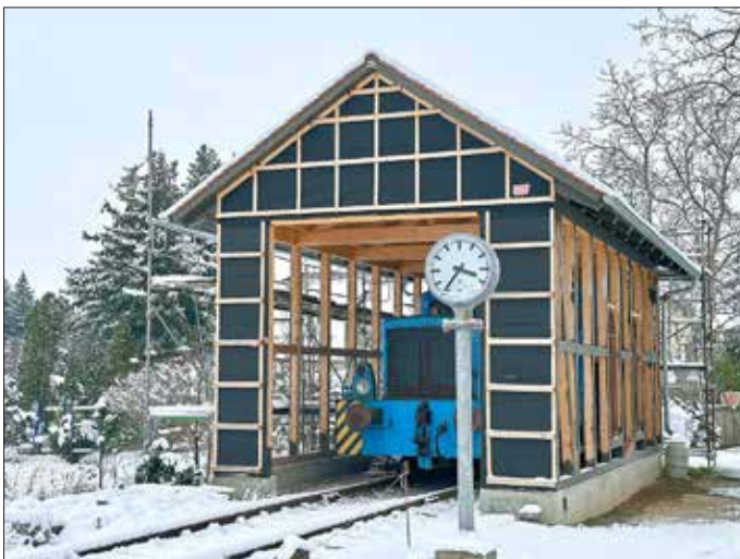
Im Dezember 2023 zeigte sich der teilweise fertiggestellte Lokschuppen im Freigelände des Museums verschneit.
