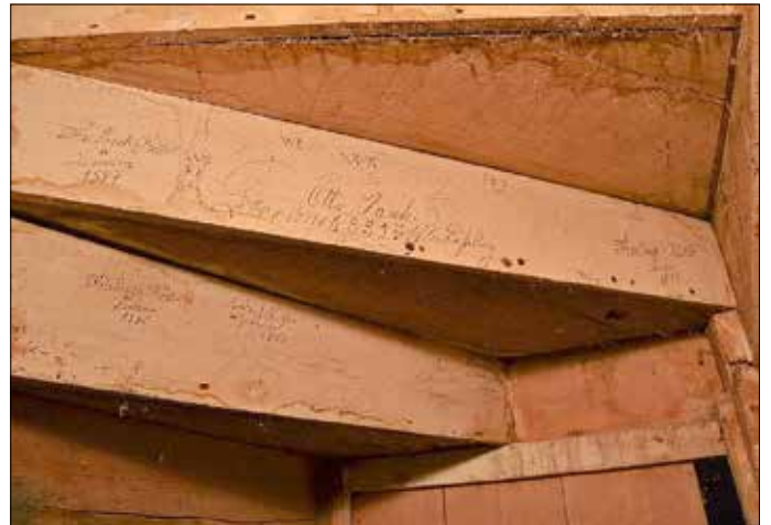
Deutlich erkennbar die Wasserflecke und die Fäulnis im Gebälk Foto: Udo Würsig
